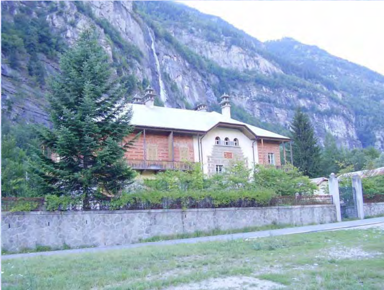
Centrale di Cadarese
